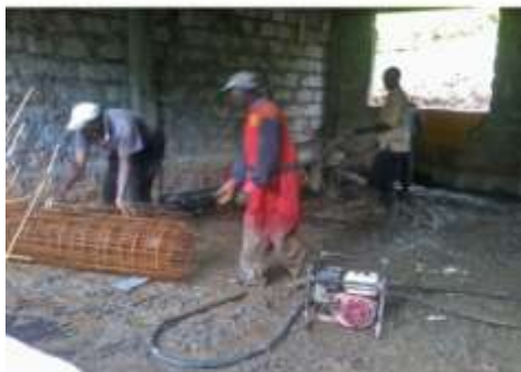
Armering og støping av gulvet
