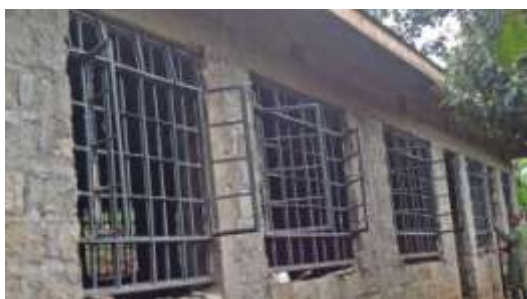
Innsetting av vinduer
